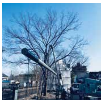
広瀬川河畔に建設中の太陽の鐘
