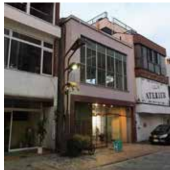
前橋工科大が取得した建物が、アーツ前橋の秋の展示「つまずく石の縁」の会場の一つとして期間限定で市民に開かれた
