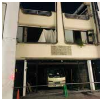
解体される直前の建物。以前は婦人服のお店が営業していたビル
