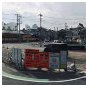
平成23年に事業が開始されており、現地では事業がかなり進んでいる様子を確認できます。
