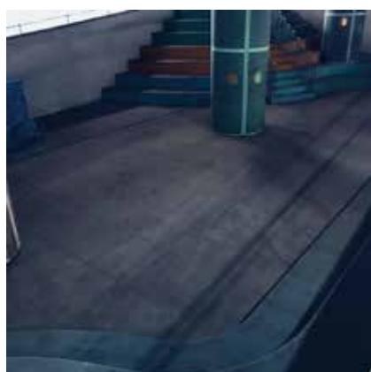
城東町立体駐車場 1階出入口のスロープの間にある広場。1階は人の出入りするところではないので、防犯上危険な箇所でもあります。もし誰かが連れ込まれても気づくことができません。現在価値がないと思われる場所の利活用で、新しい価値が創出できるはず
